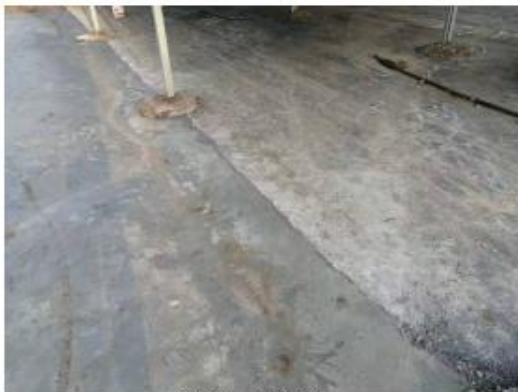
项目厂区硬化
